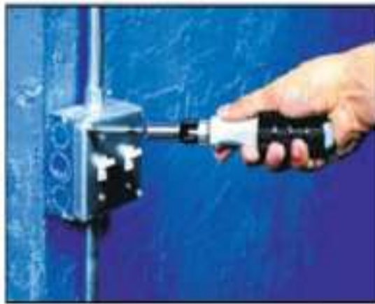
Зураг 2. Дотроо гүйдэл дамжуулагчтай төмөр хайрцагуудыг газардуулгатай холбож гүйдэлд цохиулахаас урьдчилан сэргийлдэг байна.
