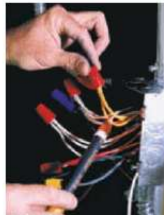
Зураг 3. Цахилгаан хэлхээтэй ажиллахаас өмнө хүчдэлгүй эсэхийг заавал шалгаж үзнэ.
