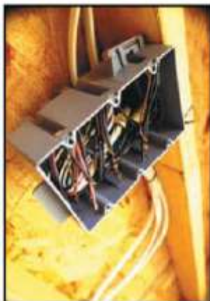
Зураг 1. Хар болон улаан утас ихэвчлэн гүйдэлтэй байдаг ба цагаан утаснууд нейтрал байдаг.
